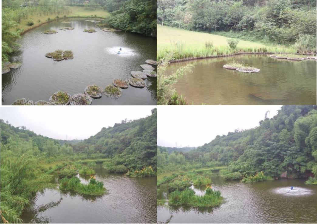
图6-10 浮床及人工水草工程（底部可见沉箱）
