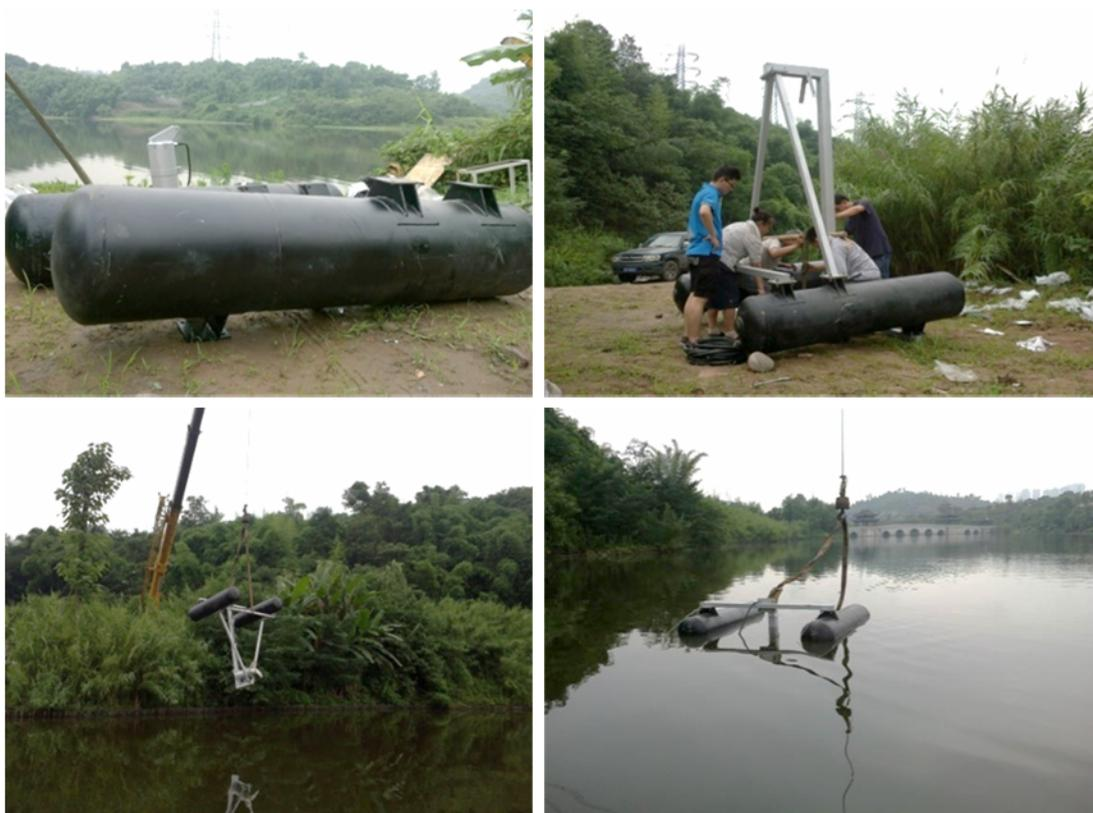
图6-7 回水区人工强化富氧示范工程图
