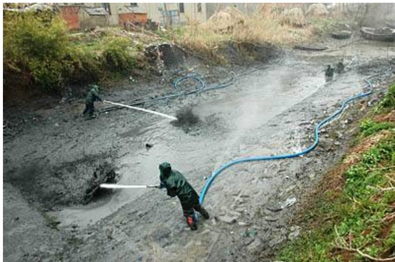
图4-6 水力冲挖清淤示意图
