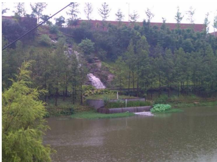
图6-14 梯级雨水前置库强化收集处理技术暴雨期溢流
