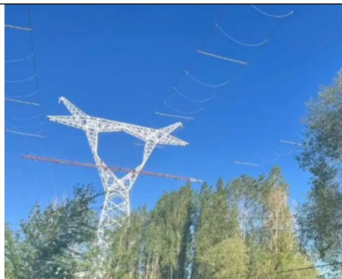
图 2-3 输电线路横担封网搭设影像实例
