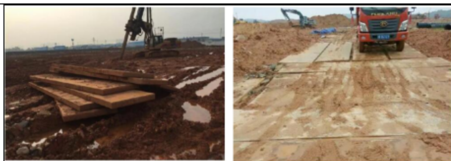
图5-5 临时道路路基箱铺设实例示意
