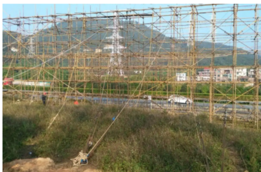
图 2-2 输电线路跨越架搭设影像实例
