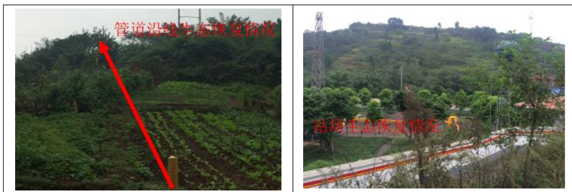
綦南线沿线生态植被恢复现状
