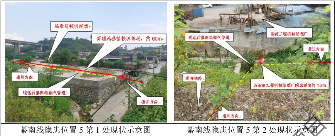
图 2.2-1 綦南线隐患位置现状图
