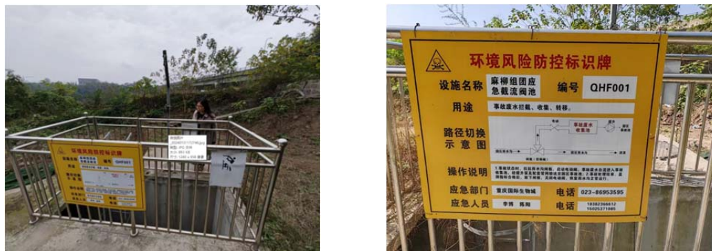
图 7.8-4 园区已建应急截流闸阀和收集池
